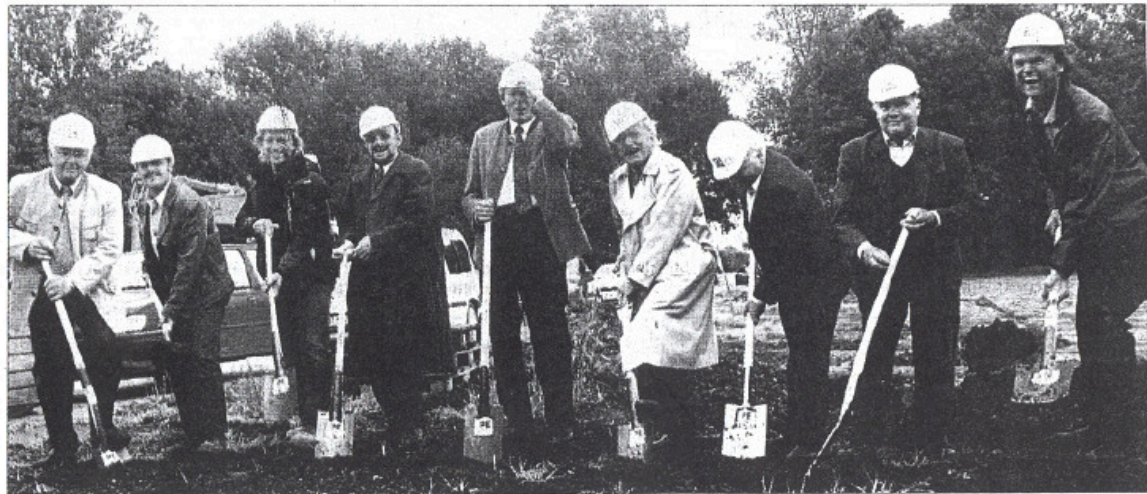
Gestern trafen die ersten energischen Spatenstiche den Boden, auf dem die neuen Stadtwerke entstehen sollen. Es packten mit an (von links): Bürgermeister Heinz Enghuber, Paul Leikam, Alexander Regler, Werkleiter Hans-Jürgen Hill, OB Dr. Bernhard Gmehling, Werkreferent Rudolf Mayr, Architekt Prof. Josef Reindl, Baureferent Raimund Kerner und Bauunternehmer Franz Georg Eltenreich. Bild: Regina Hasler
